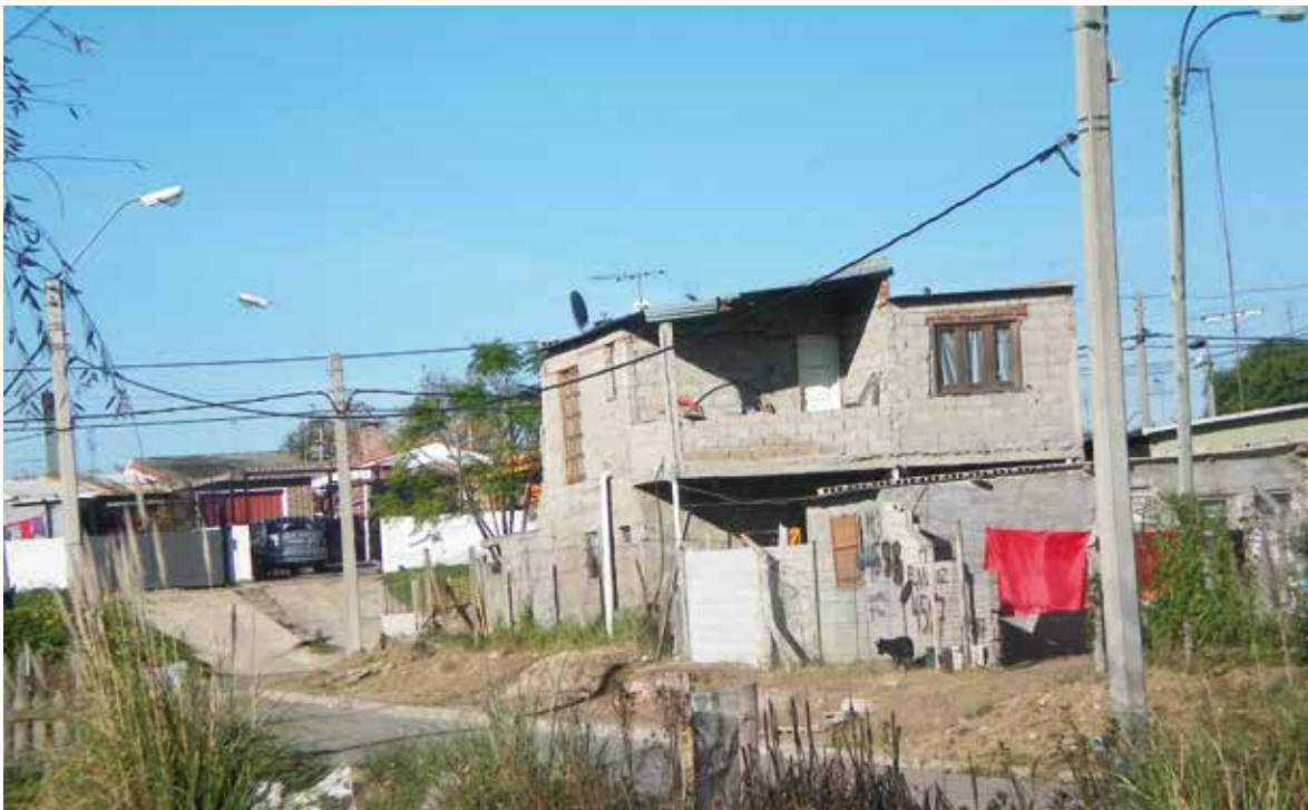
Centro CAIF del lugar, construido en el contexto de la intervención urbana del PIAI en 2008.
